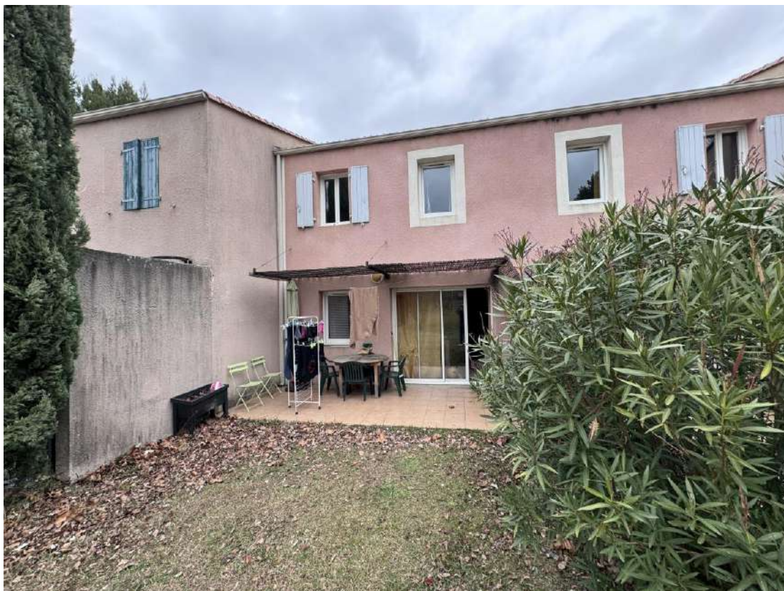
Façade côté arrière :
